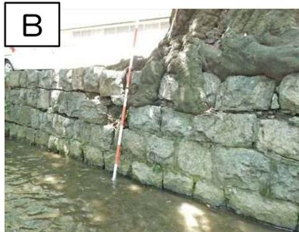
根元の肥大による護岸の損傷
