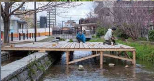
高瀬川沿いの大島桜の側に期間限定で建てられる「崇仁テラス」。 2017年から継続。
