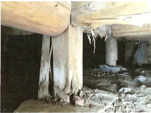
主屋本玄関 修理前
