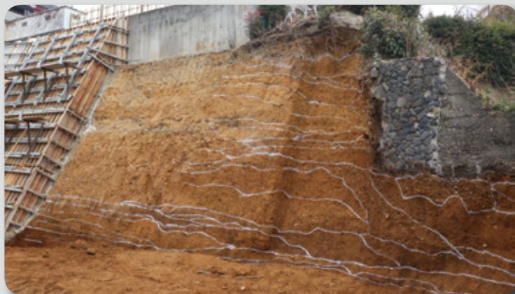
伏見城跡惣構跡の土塁断面（16～17世紀）
