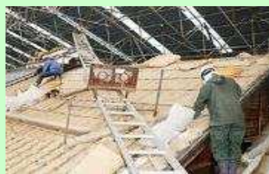
元離宮二条城本丸御殿の修理の様子
