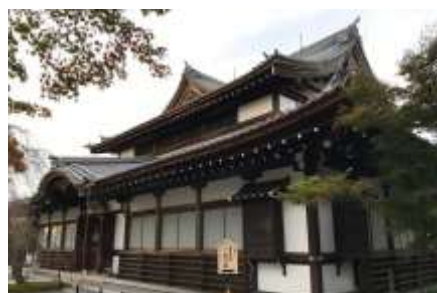
青蓮院大護摩堂外陣（旧大日本武徳会京都支部武徳殿）外観
