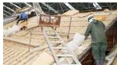
図表 153 元離宮二条城本丸御殿の修理の様子
