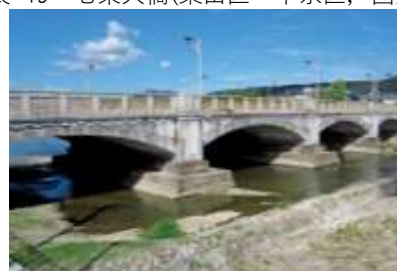
図表 49 七条大橋(東山区・下京区, 国登録)
