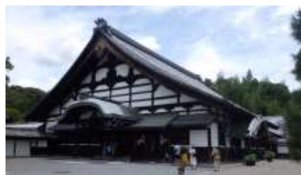
東福寺本坊庫裏 外観
