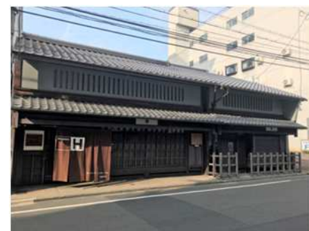
長江家住宅主屋北棟 外観（右側が主屋北棟）
