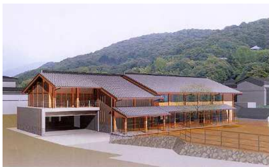
京都市文化財建造物保存技術研修センター（外観）
