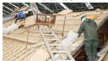
図表 153 元離宮二条城本丸御殿の修理の様子
