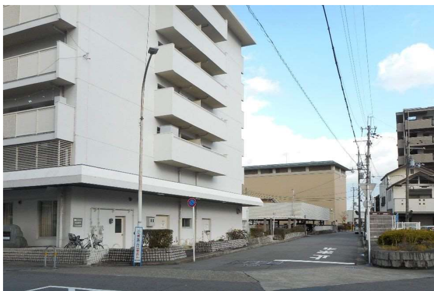
図 3.3-2(2) 近景の予測結果 (1 期工事終了時, 視点場：南西側路上)
