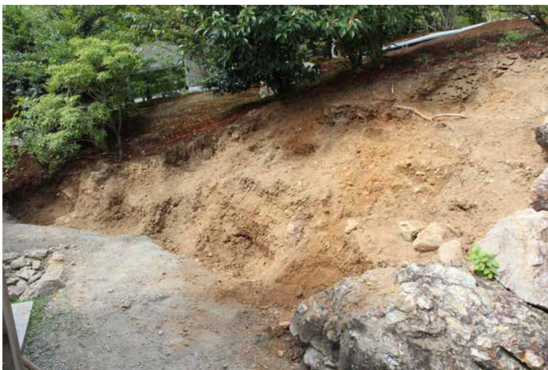
写真8 第1トレンチb区 貼石・盛土除去状況（東から・令和2（2020）年9月23日撮影）
