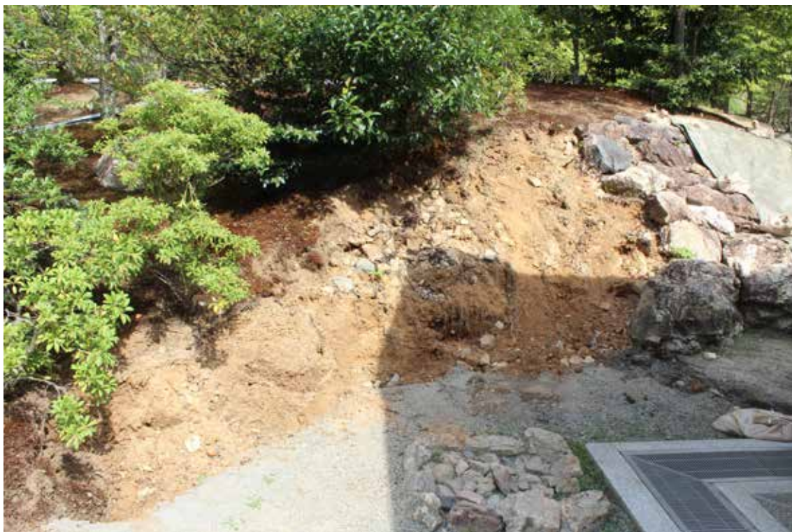
写真7 第1トレンチb区 貼石除去状況（南西から・令和2（2020）年9月23日撮影）
