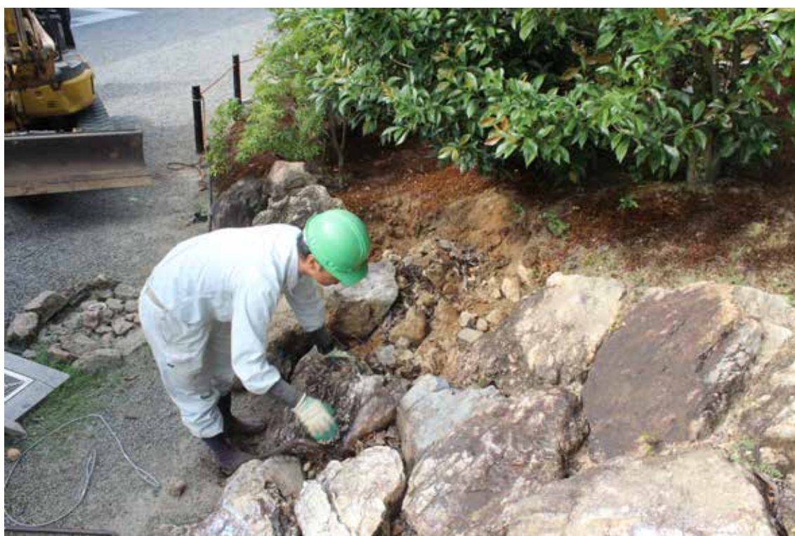
写真6 第1トレンチb区 貼石除去作業（東から・令和2（2020）年9月23日撮影）
