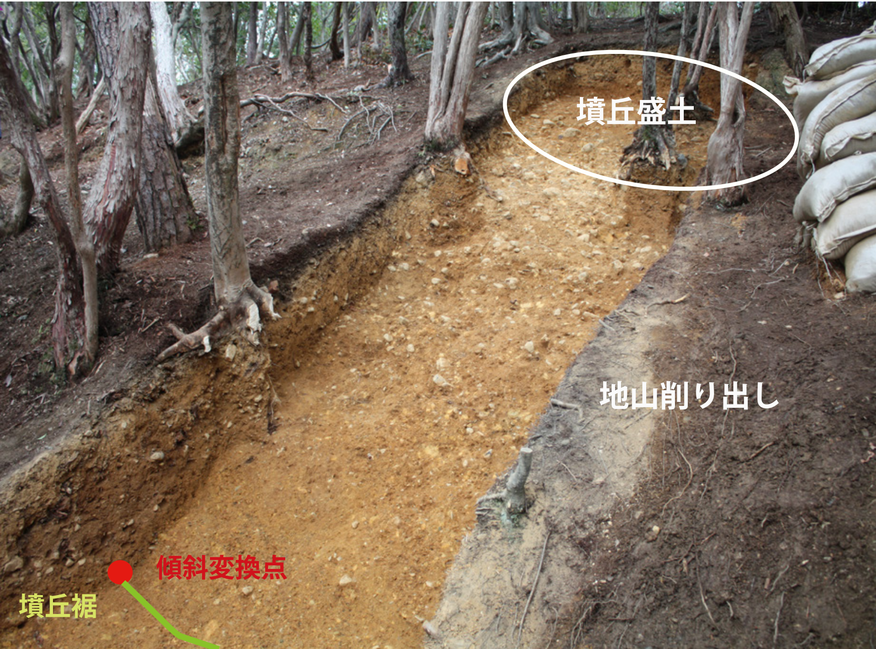
図3 7区全景（南から）
