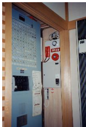
自動火災報知設備
