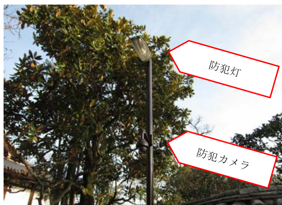
防犯カメラと防犯灯
