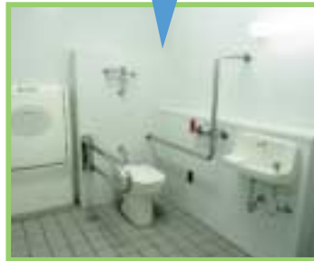
車いす対応トイレ
