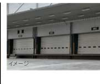
トラック荷台の高さに合わせたエプロン設置
