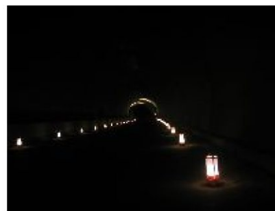
トンネル内ライトアップ
