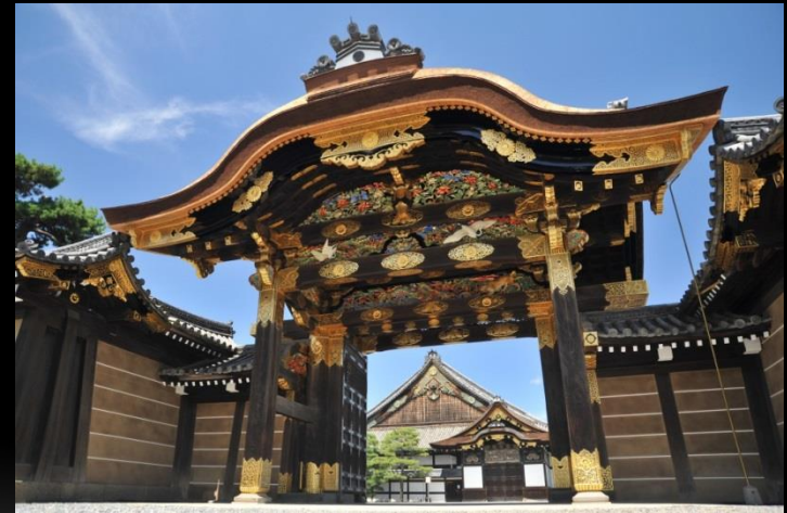
保存修理工事<後>の唐門
