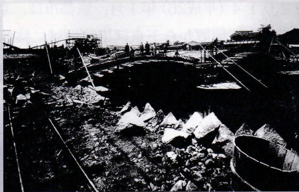
写真：工事中の七条大橋(1912(大正元)年)(京都市歴史資料館蔵)
