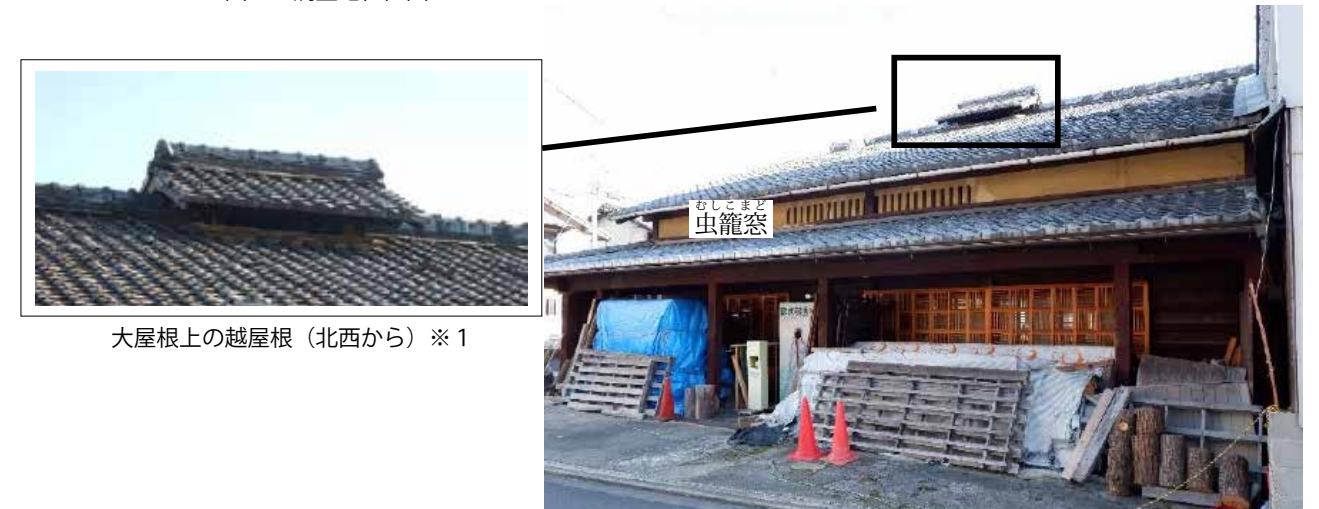
図3 建物正面（南西から）※1
