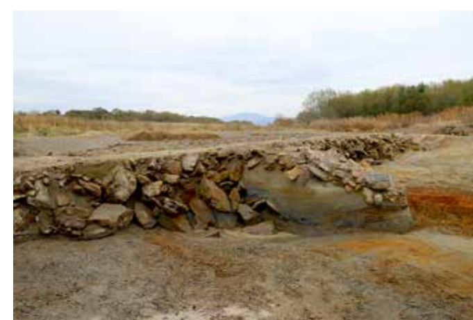
写真9 石積水制 1 断割断面 (南西から)
