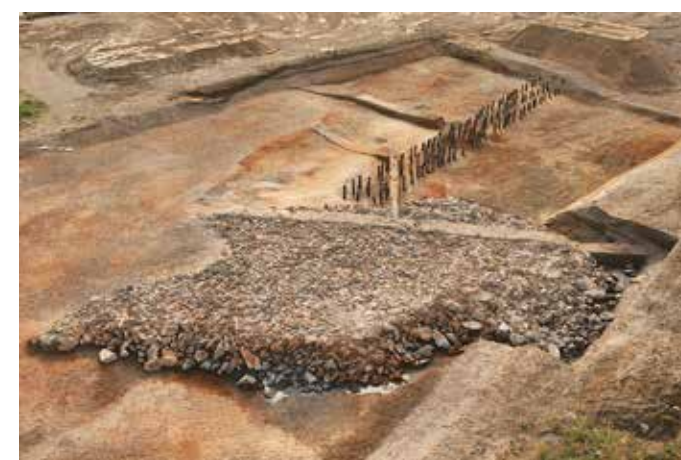
写真3 石積水制 1 (北西から)
