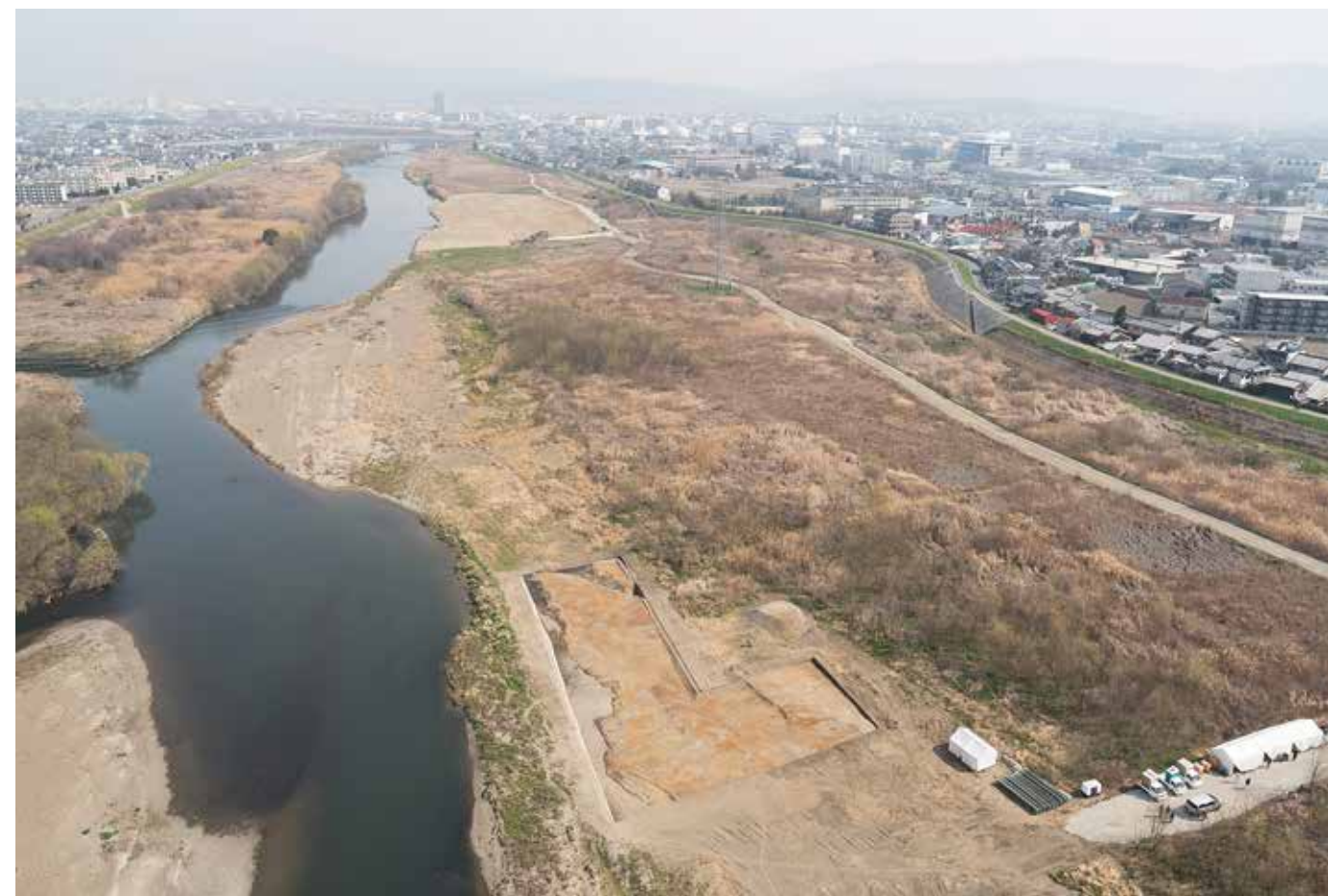
写真14 1区全景（南西から）
