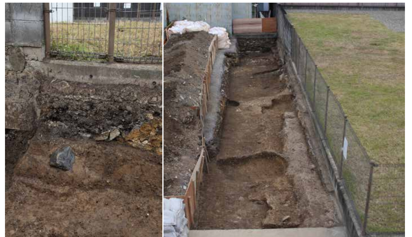
写真 1 壺掘地業 7 (南から)
