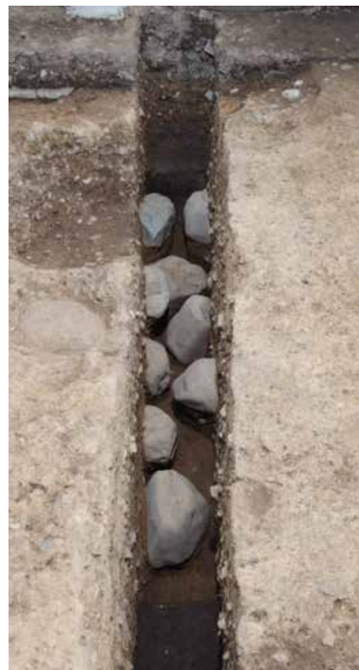
写真3 壺掘地業2（北から）
