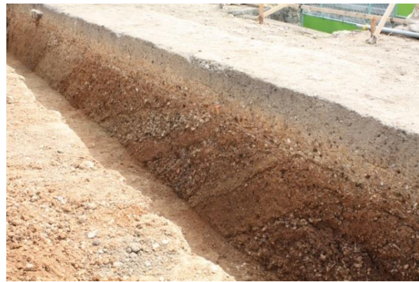
写真2 造成土の堆積状況(北東から)
