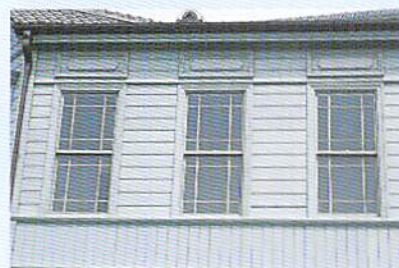
▲木製サッシの上げ下げ窓と2階窓枠上部に配した長方形のフィードバックパネル(浮き彫りのある装飾板)
