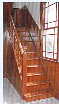
▲1階部分の階段は改変されていたため、2階部分を基に復元
