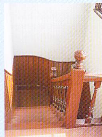
◀当時のままの階段と手すり
