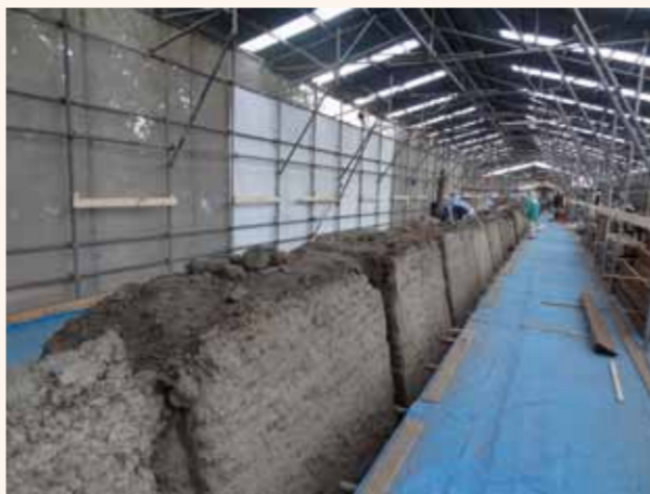
東築地塀本体の調査
