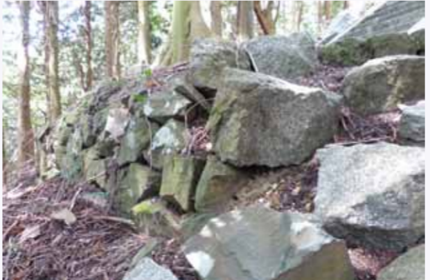
二段から三段に積まれた石垣
