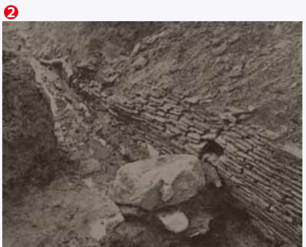
昭和九年(1934)に見発見された金堂の瓦積基壇跡
