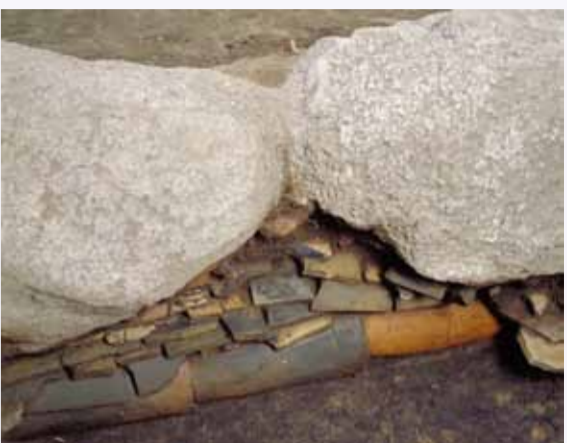
塔跡石積基壇下に残る当初の瓦積基壇跡
