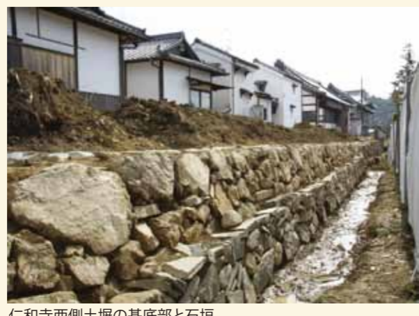
仁和寺西側土塙の基底部と石垣
