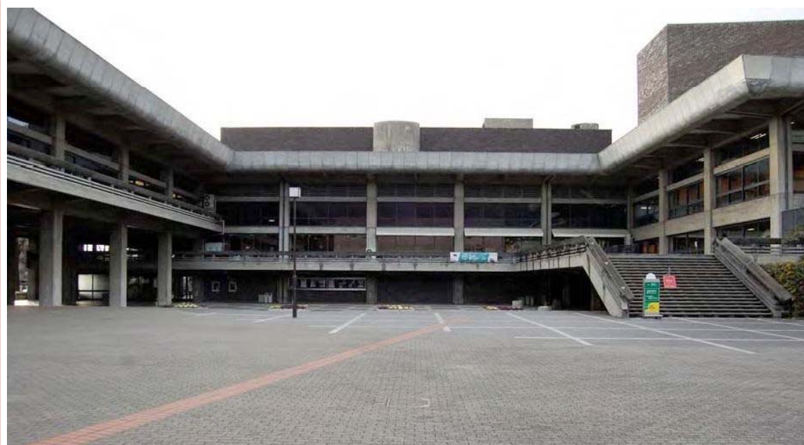
現況 中庭から建物全体をみる
