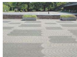
現況中庭の床仕上げ
