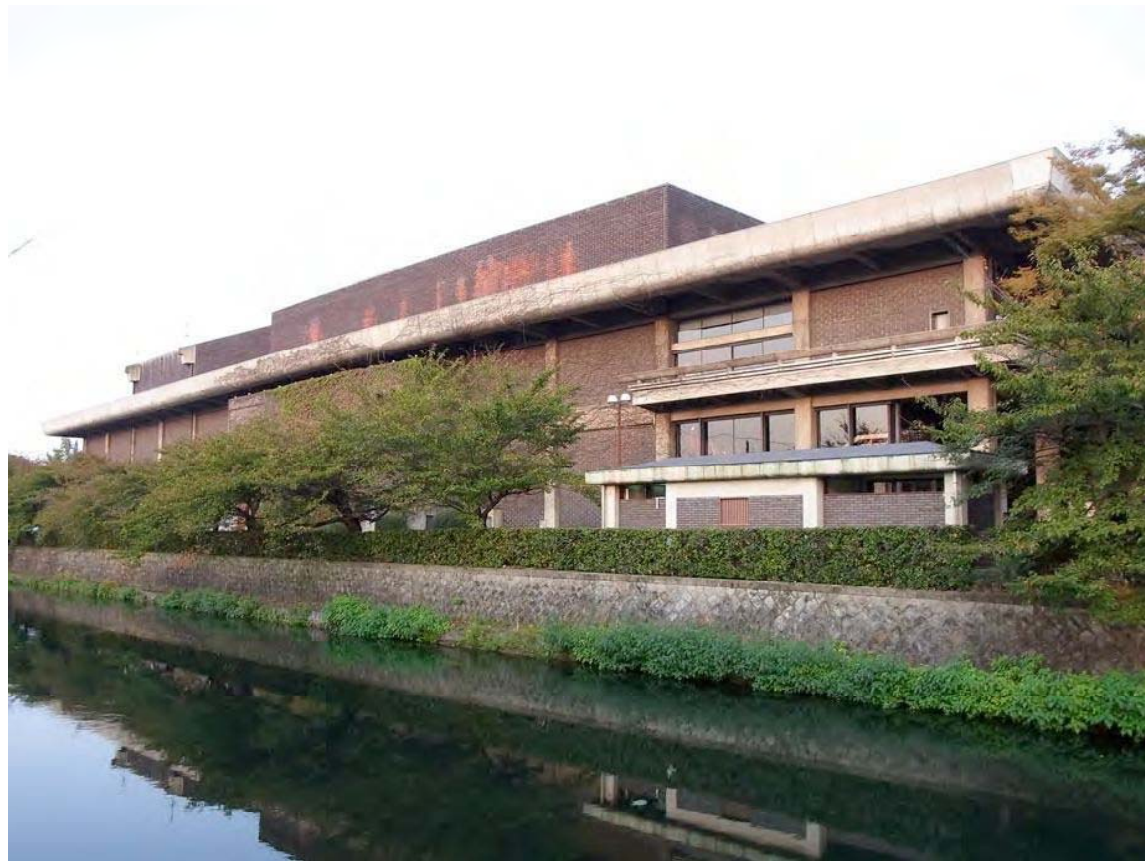
現況 二条橋側から西側立面をみる
