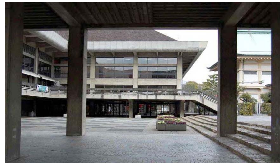
現況 ピロティから第一ホールをみる
