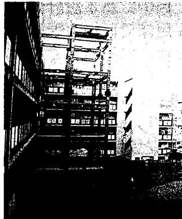
工事の状況（東から望む）
