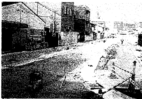
【現在工事中のコミュニティ道路】
