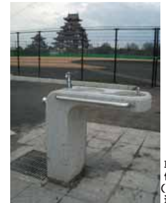
車いすのまま 使える水道 (伏見桃山城 運動公園)
