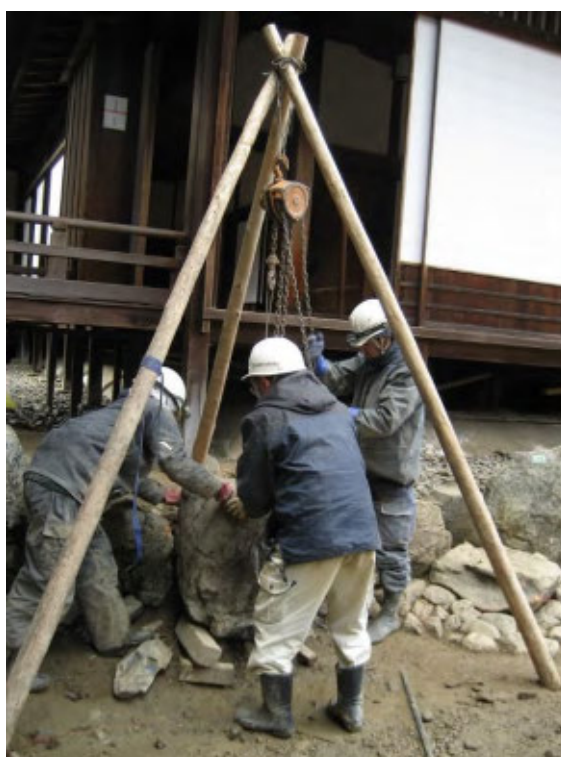
写真7 庭園修理状況（醍醐寺三宝院庭園）
