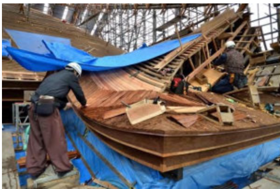
写真 4 建造物修理現場
