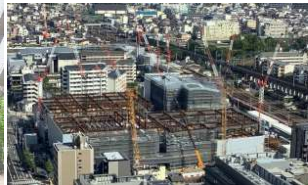
工事の様子（2022年9月）
