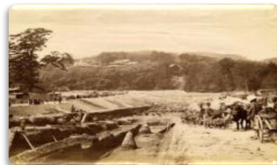
<琵琶湖疏水(建設当時)>
