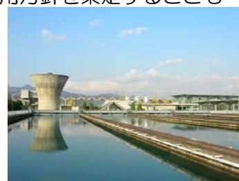
山ノ内浄水場
