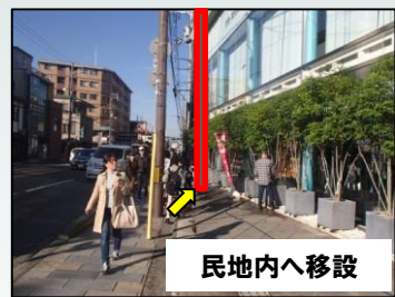
電柱等の移設箇所
