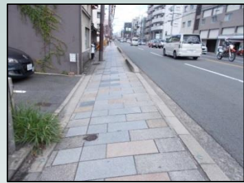
歩道の横断勾配改善箇所
