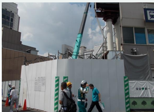
工事中の西院駅西改札口
