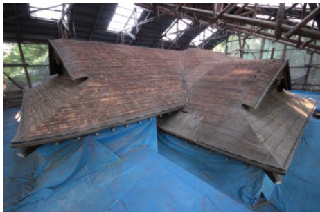
旧三井家下鴨別邸(玄関棟屋根葺替工事中)
