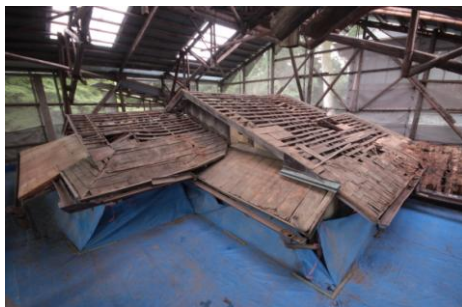
旧三井家下鴨別邸(茶室屋根葺替工事中)
