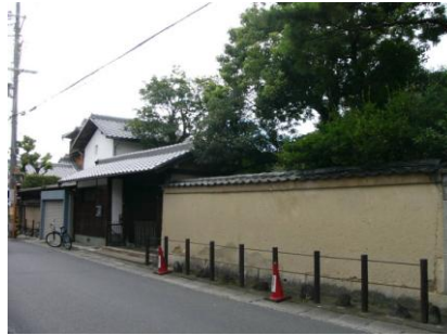
長屋門及び塀写真(平成22年指定時)
