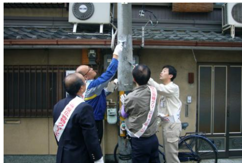
写真 7-27 屋外広告物の簡易除却
