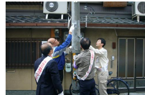
写真 7-27 屋外広告物の簡易除却
