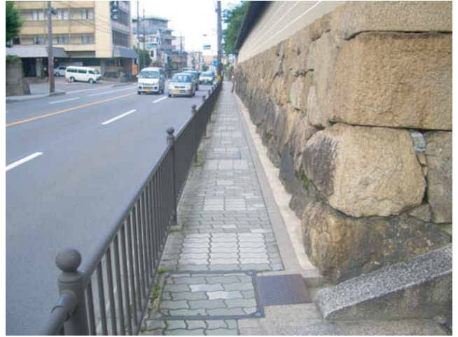
馬町周辺の歩道状況
