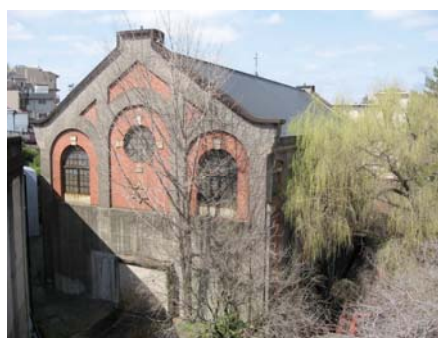
写真2-94 蹴上発電所(非公開)
