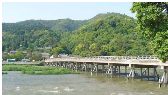
写真2-115 大堰川 渡月橋
