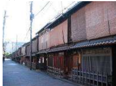
写真3-12 祇園新橋地区
