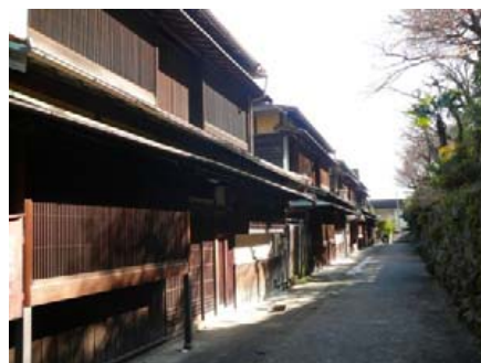
写真2-103-2 良好な住宅群（谷川住宅群）
