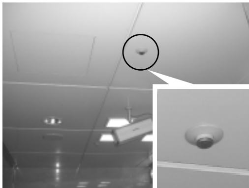
スプリンクラーヘッド（天井埋込形）
