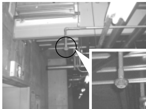
スプリンクラーヘッド（露出形）
