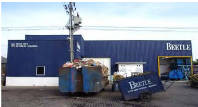
中間処理施設
