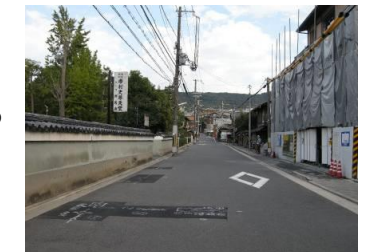
八坂通沿の工事現場
