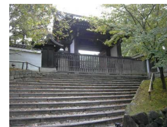
青蓮院四脚門
