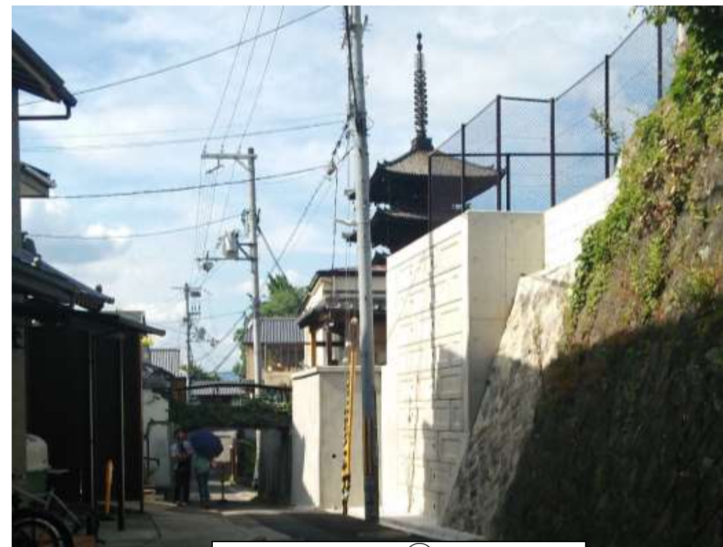
写真⑳ 敷地境界に直立するコンクリート擁壁
