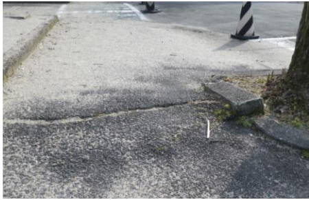
舗装の老朽化
