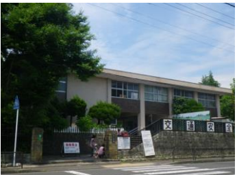
【写真③】管理棟
