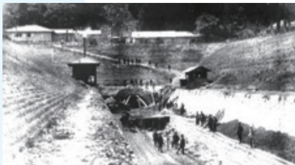
第1疏水第2トンネル東口洞門工事
