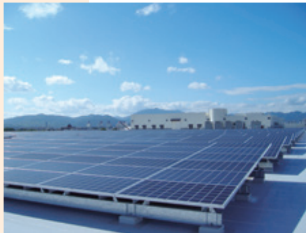
鳥羽水環境保全センター 大規模太陽光発電設備
