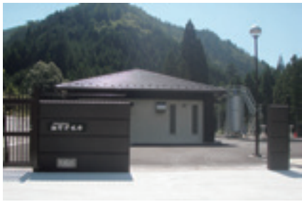
再整備後の細野浄水場(旧京北地域水道)
