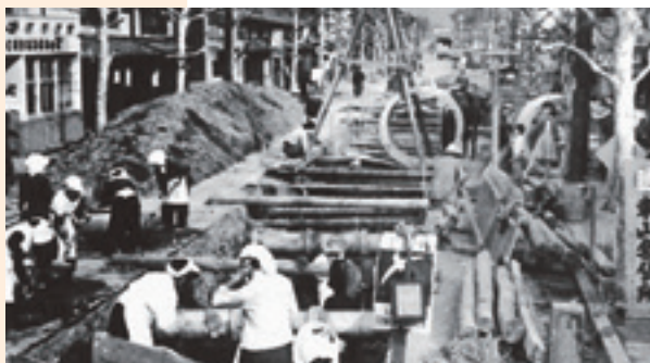
管布設工事(川端二条東入ル)
