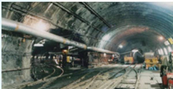
第2疏水連絡トンネル
