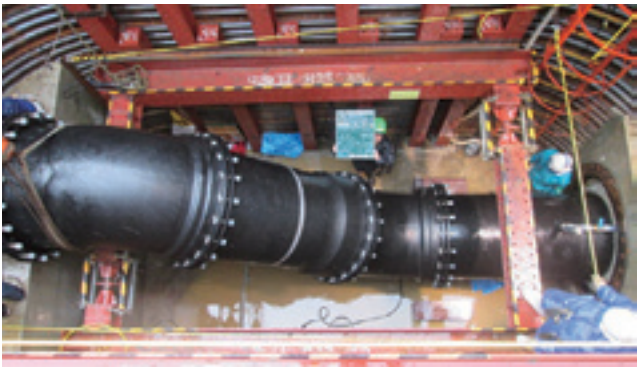
水道配水管更新工事
