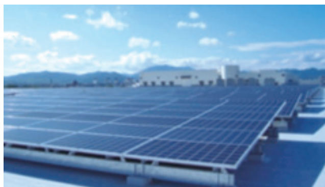
大規模太陽光発電設備（鳥羽水環境保全センター）
