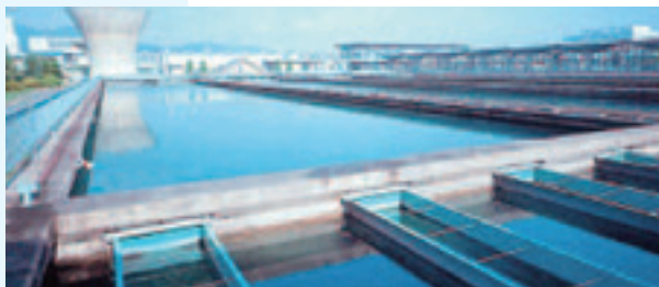
山ノ内浄水場
