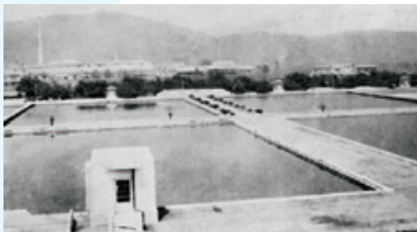
松ヶ崎浄水場
