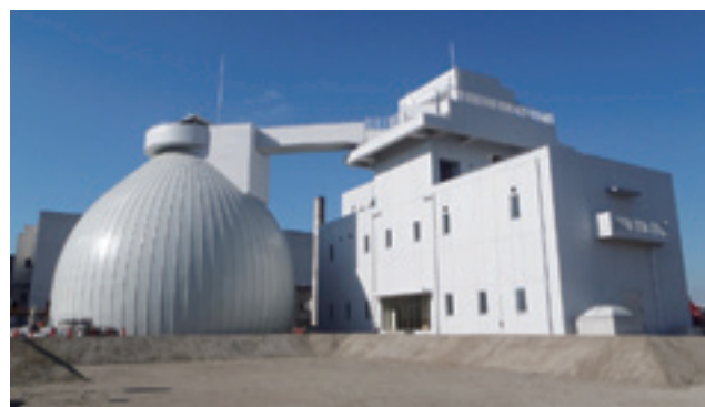
汚泥消化タンクの再整備
