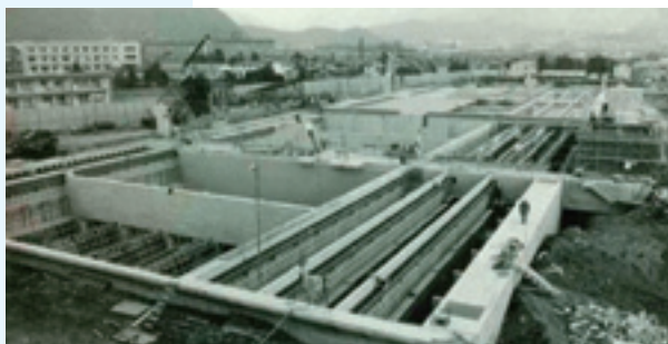
松ヶ崎浄水場拡張工事
