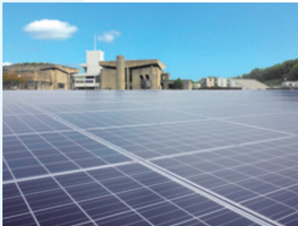
新山科浄水場大規模太陽光発電設備
