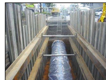
老朽化した水道管の更新
