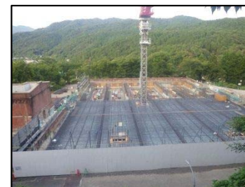
第1高区配水池(蹴上浄水場)の更新
