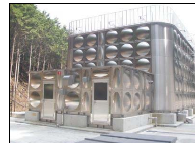
周山配水池(京北中部地域水道)
