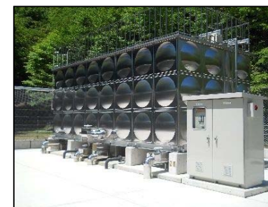
余野配水池(細野地域水道)
