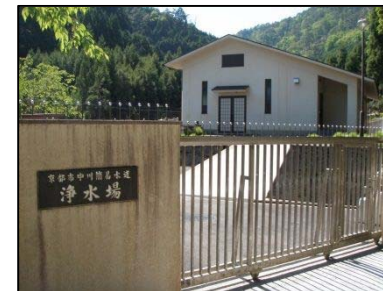
中川浄水場(中川・小野郷地域水道)
