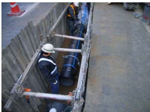
水道配水管更新工事
