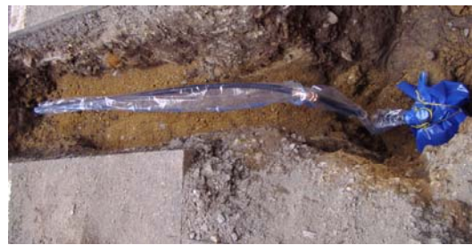
左：鉛管 右：取替後
