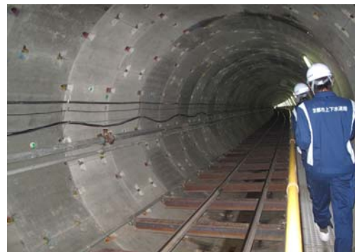
雨水幹線工事現場
