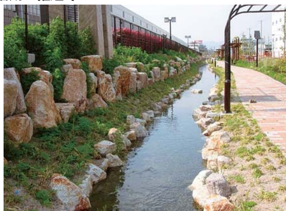
高度処理水を利用したせせらぎ水路
