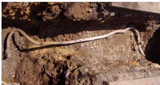
左：鉛管 右：取替後
