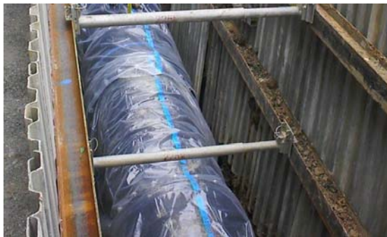
水道耐震管の布設
