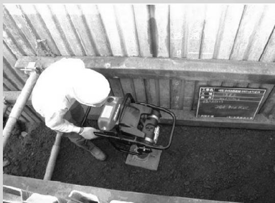
下水道管布設工事（埋戻し）
