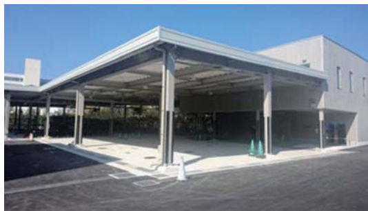
水道技術研修施設
