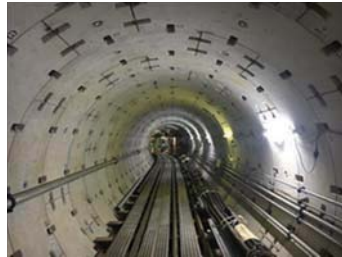
整備中の雨水幹線
