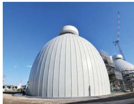
鳥羽水環境保全センター汚泥消化タンクの再整備
