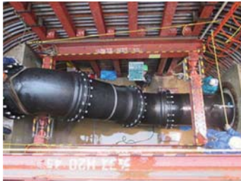
配水管更新工事
