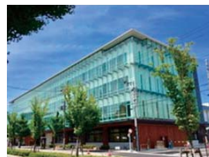
太秦庁舎の外観
