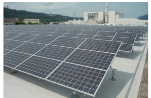
石田水環境保全センターの大規模太陽光発電設備
