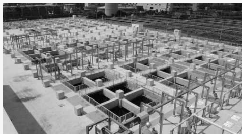
鳥羽水環境安全センターB系水処理施設
