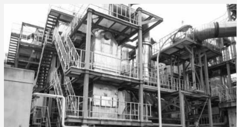
汚泥焼却炉（鳥羽水環境安全センター）
