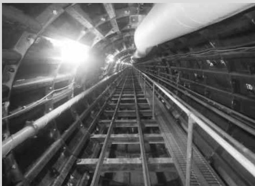
工事の様子 （朱雀北幹線）
