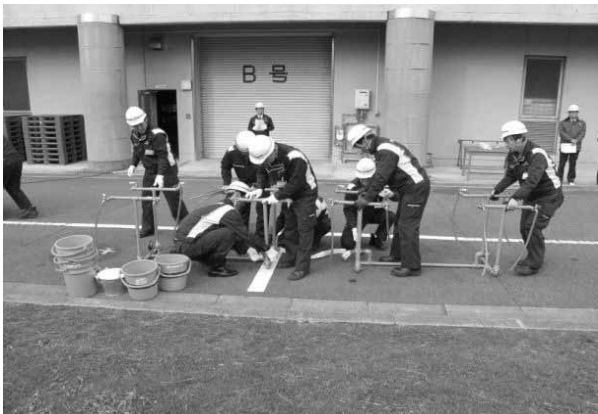
応急給水訓練（仮設給水栓の組立作業）の様子
