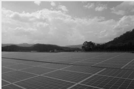
大規模太陽光発電設備（松ヶ崎浄水場）
