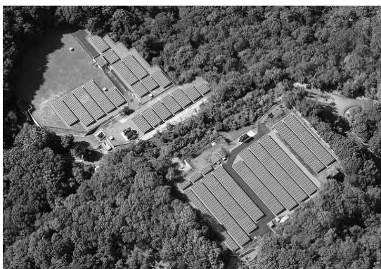
松ヶ崎浄水場の大規模太陽光発電設備
