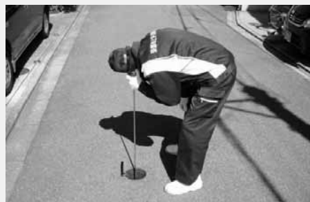
漏水調査作業
