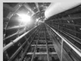
工事の様子 （朱雀北幹線）
